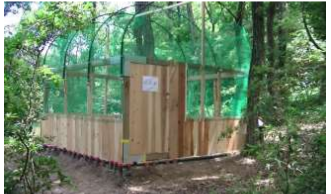
防腐塗料の塗布作業を残して一応完成。あとはカブトムシの自然の中での棲み心地を考えたり、観察に適した内装を進めていくこと。また、伐採せずに囲うようにして残した中のコナラが、うまく樹液を出してくれるようになるのを期待したい。
