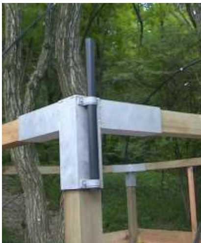
天井部に取り付けるアーチ状の樹脂パイプの取付方法を設計変更。一サイズ太い樹脂パイプ(長さ600)を受けパイプとして側面8ヶ所に固定
