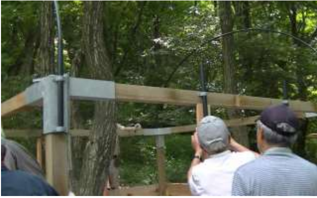
側面 8ヶ所に固定した受けパイプに、アーチ状の天井パイプ 4 本を差し込んでいく。
