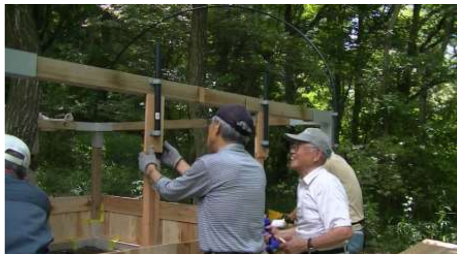
天井部に取り付けるアーチ状の樹脂パイプの取付方法を設計変更。一サイズ太い樹脂パイプ(長さ600)を受けパイプとして側面8ヶ所に固定
