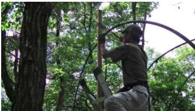
4本のアーチパイプをてっぺんで固定させるためのてっぺん木の取付。(右側)
