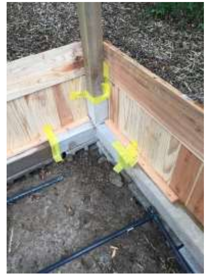
コーナーアルミ枠のすきまをテープで雨じまいの仮処置 後日シリコンシーラントでの防水処理を行う予定
