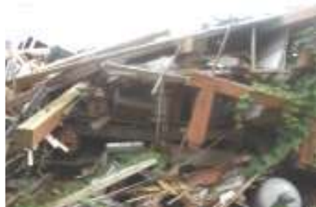
壊れた家の解体作業は遅れがち
