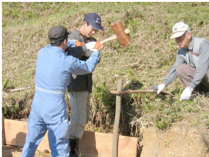
土砂崩れ跡の土留め作業
