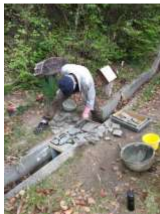
入口の排水溝のふたは、今までコナラの枝を活用していたが、腐食によるけがの心配があったが、今回U字ブロックの橋に改修。
