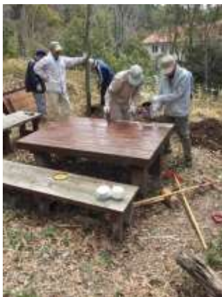
日頃なかなか行き届かない林内の施設の補修。ミーティングテーブルの補修塗料の塗布作業もそのひとつ。
