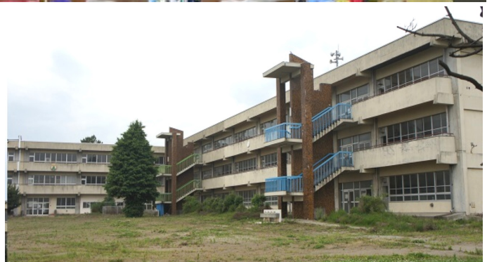
【写真説明】中段㊦＝4日、清水仮設で18期Gチームがチンドン屋で人集め。㊧＝4日、清水仮設で七夕づくり 下段㊦＝3日、女川町体育館で施設からの参加者と一緒でダンス大会。㊧＝津波に襲われ廃校になった閉上小学校の旧校舎。近くに同じく廃校になった中学校もある。
