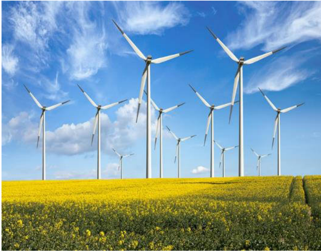
大電量風力発電機
