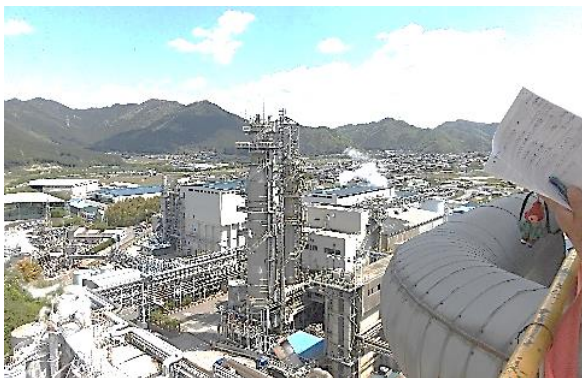
屋上から連続蒸解釜を臨む
