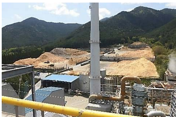
屋上からパルプ用原料置き場（手前）と 発電用燃料置き場（奥）を臨む
