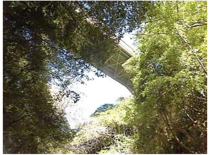
取水地点：大月大橋を見上げる
