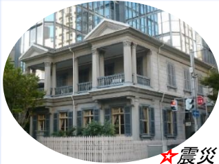
★震災で再建された市内 最古の洋風建築物”旧居留地15番館“
