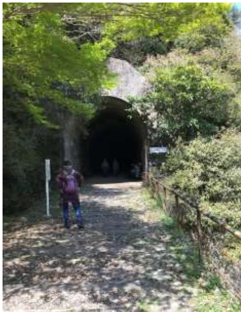
溝滝尾トンネル
