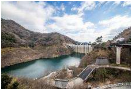
ダム湖側から見たダム全景
