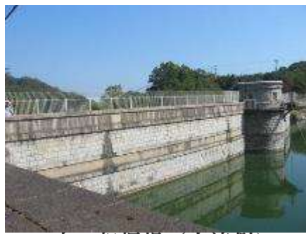
立ヶ畑堰堤（上流側）
