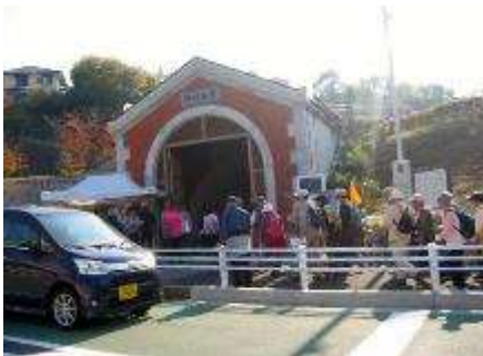
湊川隧道の入り口
