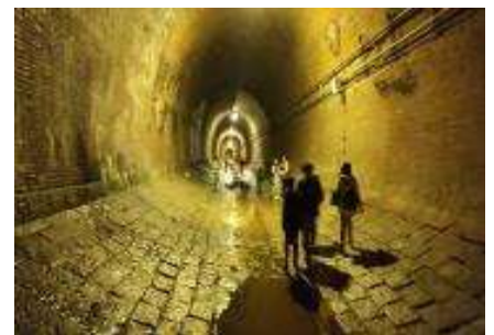
隧道のほぼ中間
