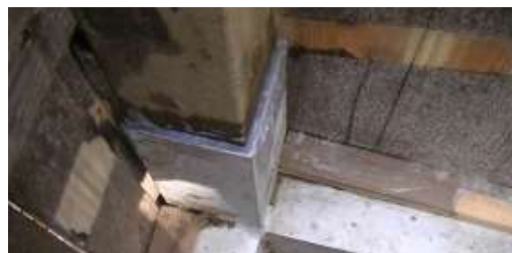
観察小屋で残っていたコーナーフレーム部のシール作業を完了させる。
