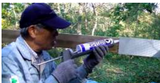
観察小屋で残っていたコーナーフレーム部のシール作業を完了させる。
