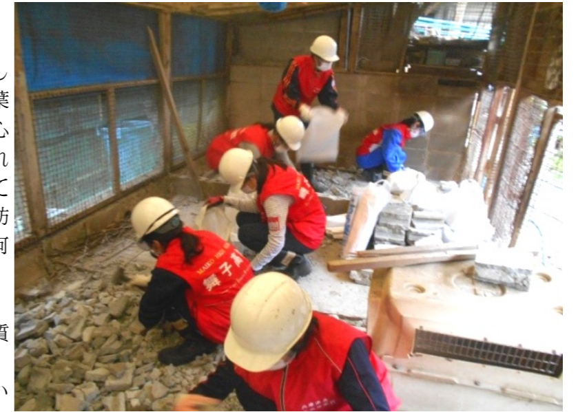
熊本地震の益城町でガレキ撤去のボランティア活動
